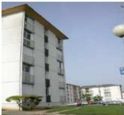
Résidence "Les Coquelicots" avant travaux
